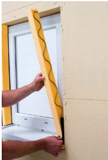
Befestigung bzw. fixieren bis zum Aushärten des Klebers mit Nirosschrauben.
